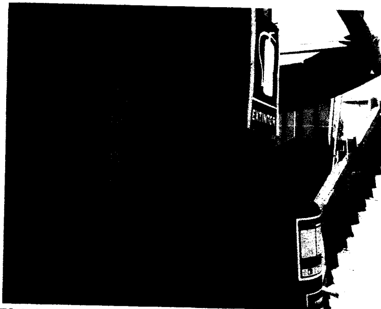
FOTO 9: Se muestra los implementos de emergencias, en la estación ubicada junto a la caseta de vigilancia
