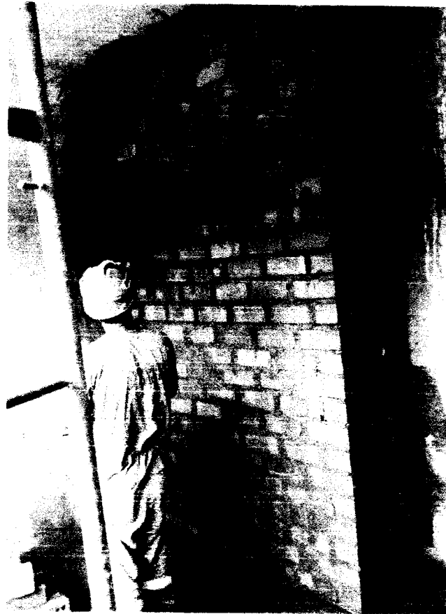
FOTO N° 07: Construcción de muros en ducto de administración.
