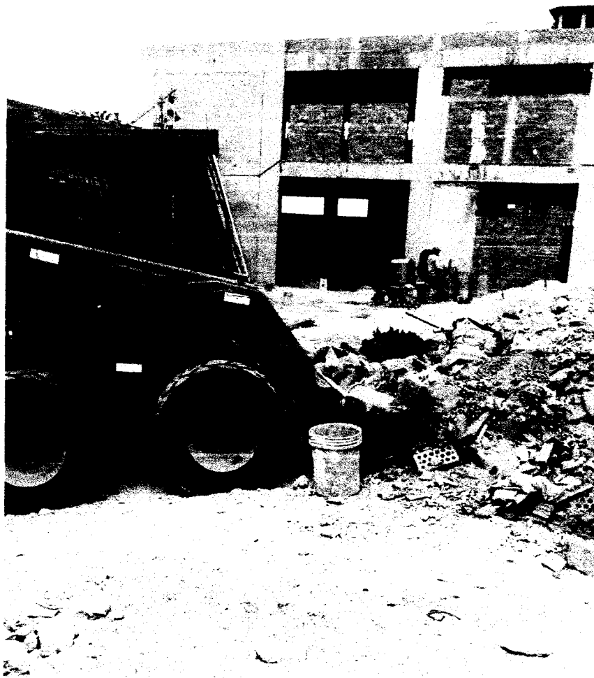
FOTO N° 01: Limpieza de obra.
