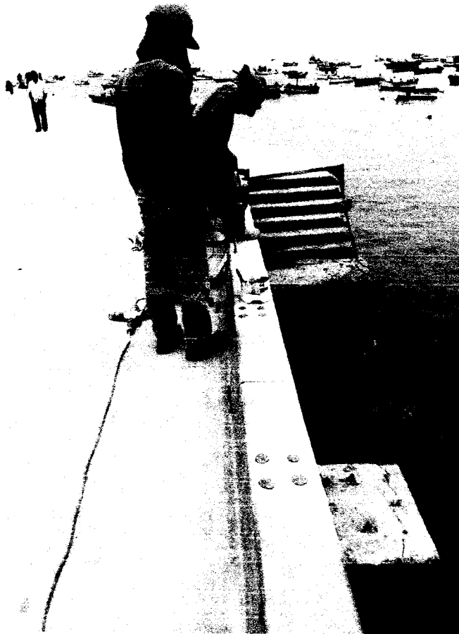
FOTO N° 10: Colocación de anclaje para barandas.
