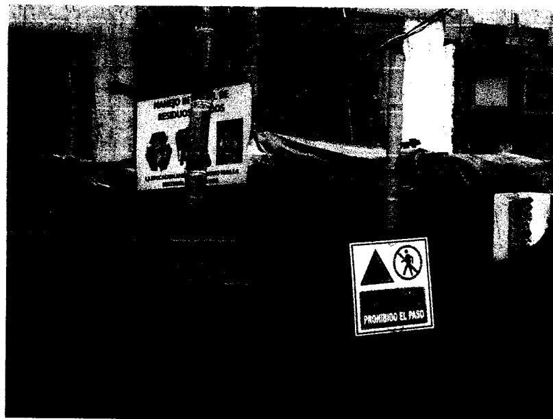
Foto 7: señalización en el exterior de la obra
