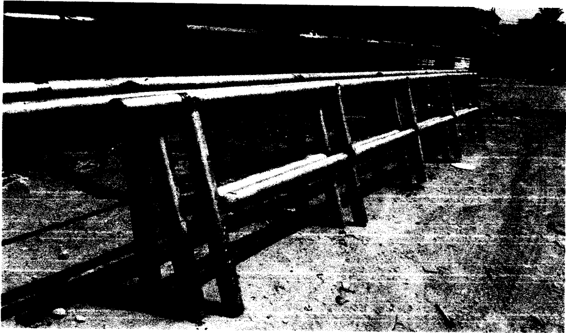
FOTO N° 09: Barandas de acero galvanizado.
