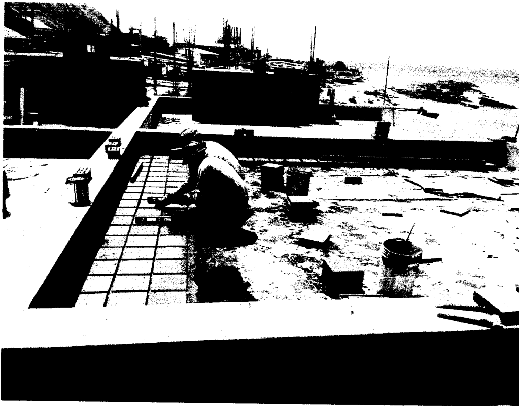
FOTO N° 04 y 05: Colocación de ladrillo pastelero.
